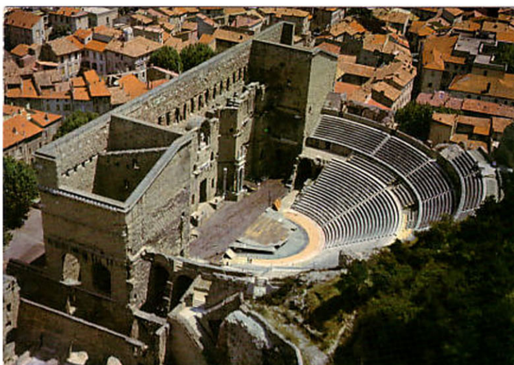
Fig. 38. Vista aérea del teatro de Orange (Francia).
